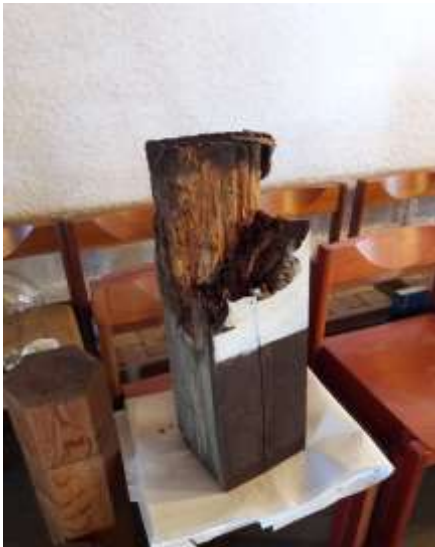
Balken im Kirchturm
